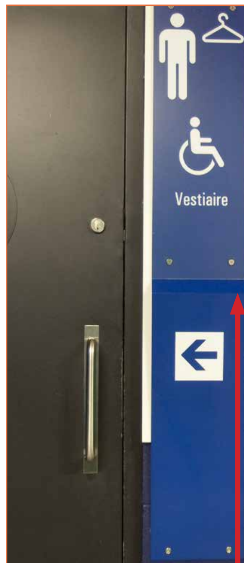
Signalisation en braille Identification d'un local — côté poignée
