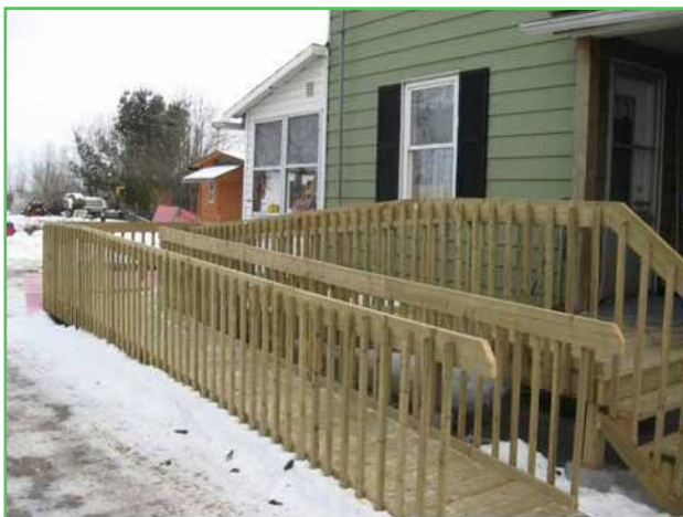
Rampe d'accès en U avec palier
