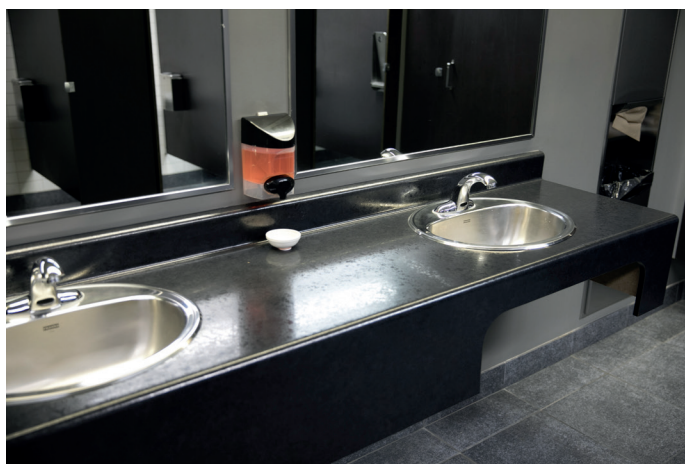
Description : Robinetterie à manette unique, Centre sportif, secteur de Gatineau. Robinets à détecteur de mouvement, centre sportif, secteur de Gatineau
