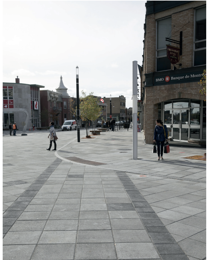
Description : installation de plaques podotactiles, Promenade du Portage, secteur de Hull
