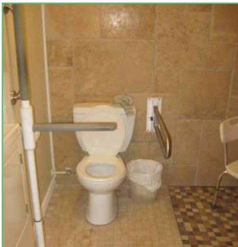
Toilette avec barres d'appui
