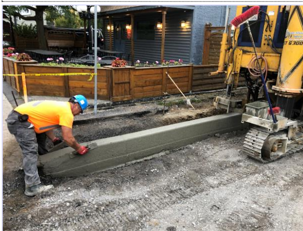
Réfection des services municipaux 17-3055 / John Helenore, Derwin (en travaux)
