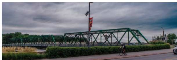
Boulevard Gréber Pôle commercial attractif et de services
