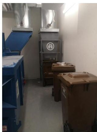
Arrivée des chutes avec conteneur et bac brun
