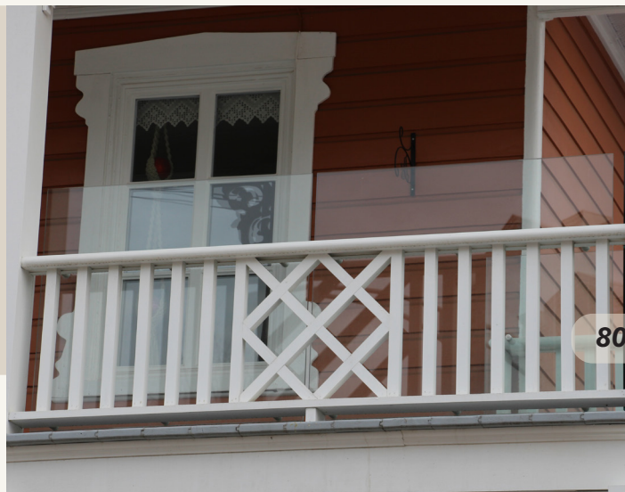
Garde-corps à l'étage mis aux normes à 1070 mm (42 po)
