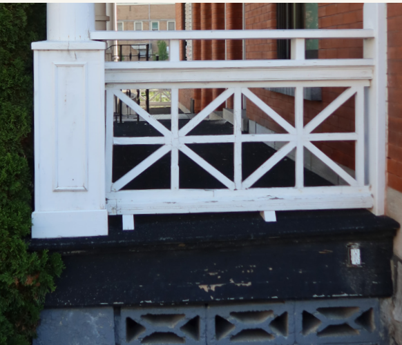
Garde-corps au rez-de-chaussée mis aux normes à 900 mm (36 po)
