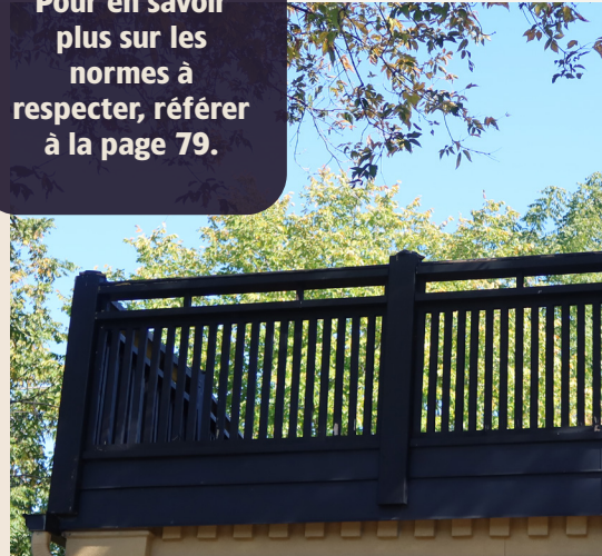
Garde-corps à l'étage mis aux normes à 1070 mm (42 po)
