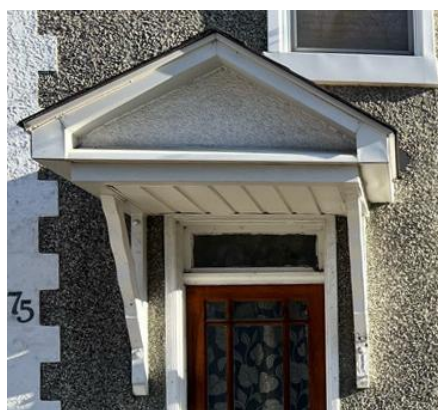
Exemple d'auvent supporté par des équerres.
