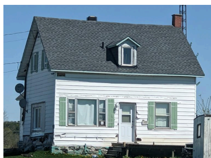
Parement non traditionnel en aluminium
