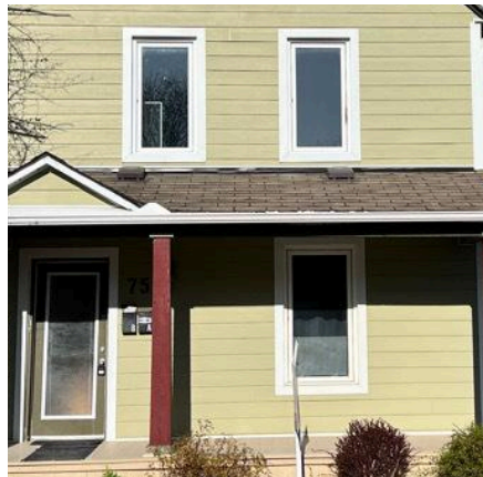
Parement non traditionnel de fibro-ciment, imitant l'aspect du bois. Grandes planches texturées disposées horizontalement.
