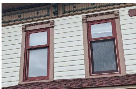
Exemple de chambranles autour des ouvertures
