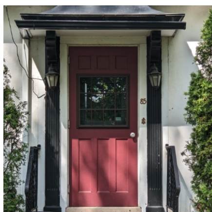
Exemple de porte encadrée par des pilastres.
