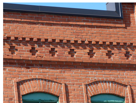
Exemple d'un appareillage de brique
