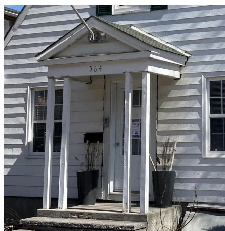
Exemple d'un auvent à fronton supporté par des colonnes
