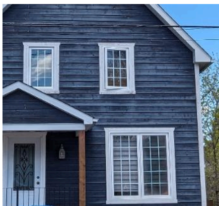
Exemple de chambranles contemporaines autour des ouvertures
