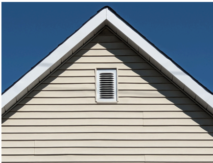
Parement non traditionnel de vinyle ou aluminium (le plus récurrent). Longues planches étroites horizontales emboîtées.
