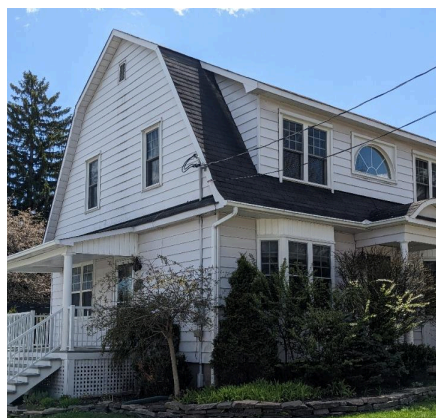
Parement non traditionnel en aluminium
