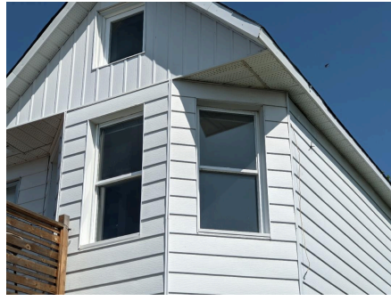
Parement non traditionnel en aluminium
