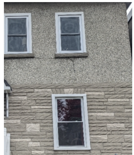
Revêtement imitant la pierre au rez-de-chaussée et agrégat à l'étage.
