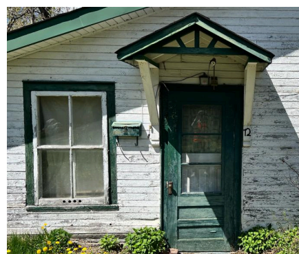
Exemple d'auvent sans colonnes marquant l'entrée secondaire
