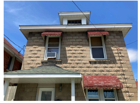
Murs en blocs de béton
