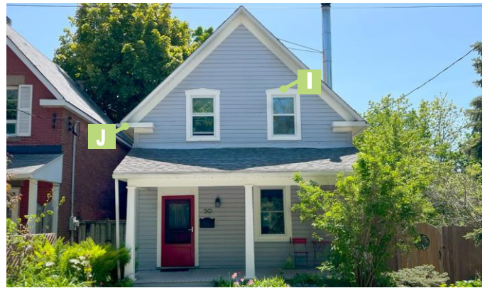
Maison à deux fenêtres à l'étage avec chambranles en bois 50, rue Thomas Ville de Gatineau
