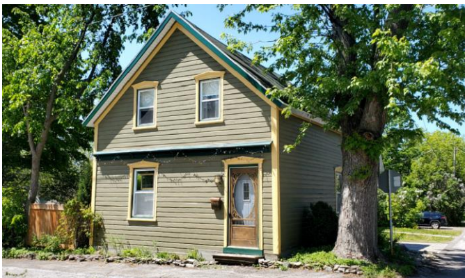
Maison à deux fenêtres à l'étage 11, rue Neil-O'Donnell Enclume
