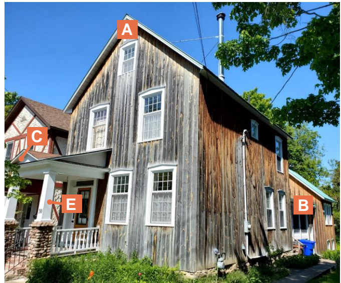
Maison allumette avec un corps secondaire à l'arrière et un porche avec fronton triangulaire soutenu par des colonnes de bois 30, rue Hanson
