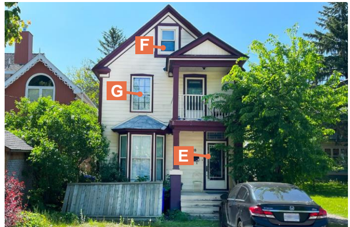
Maison avec porte fenestrée, fenêtre à guillotine avec 12 carreaux et fenêtre dans le pignon 16, rue Taylor Enclume
