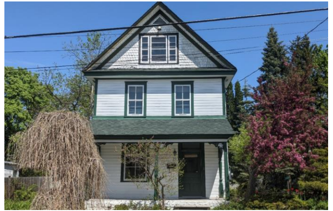
Maison avec chambranles en bois et galerie en appentis 21, rue du Couvent Passerelles
