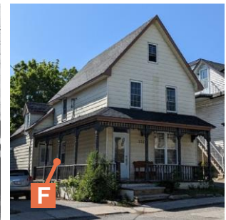
Maison avec une galerie en L 237, rue Notre-Dame-de-l'Île Passerelles
