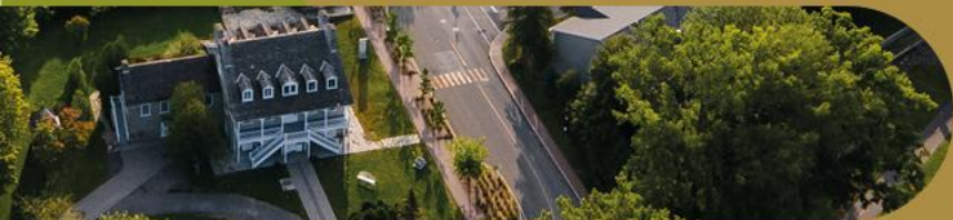
Démolition - 1025, rue Georges
