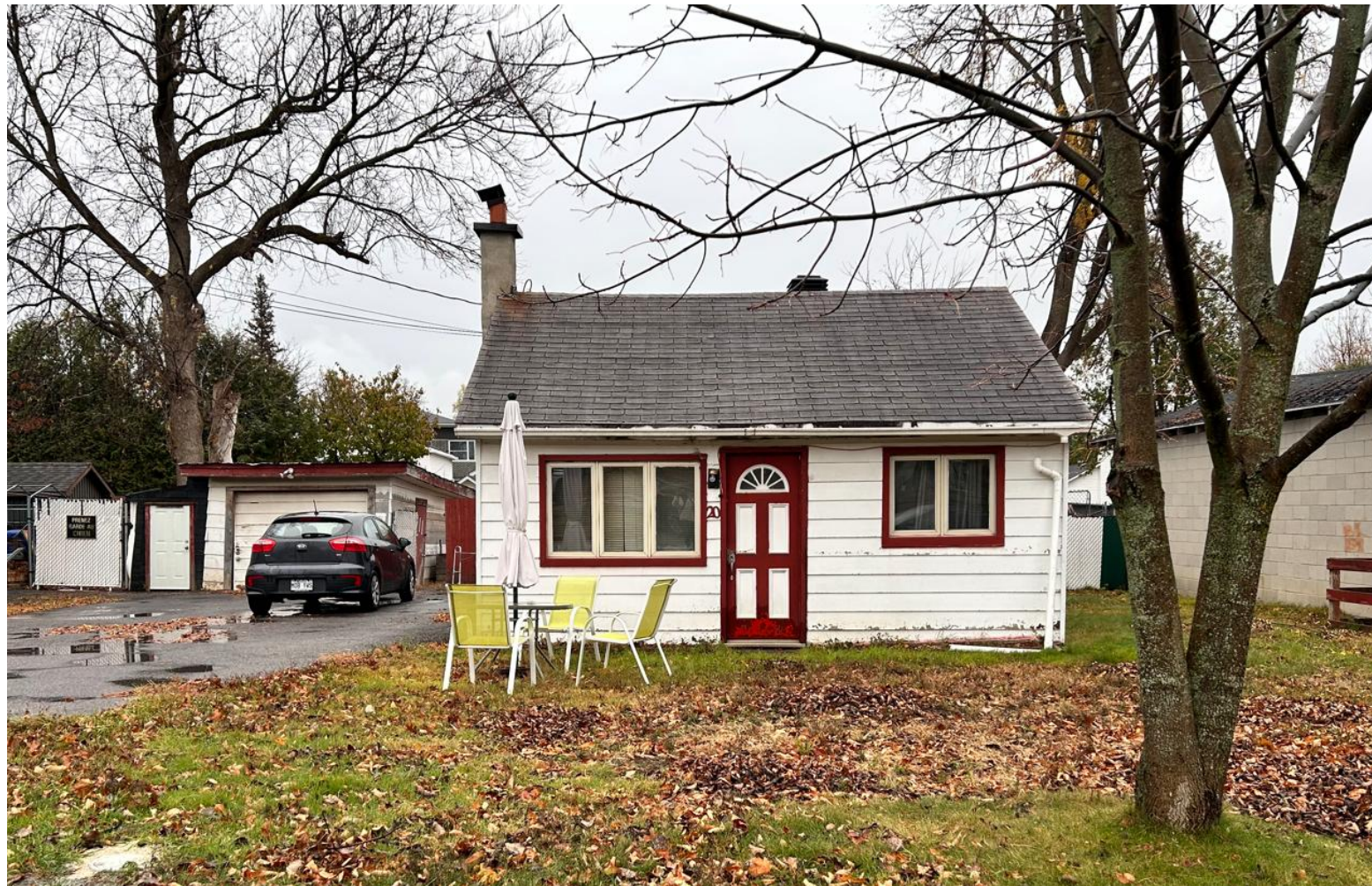
Démolition - 20, rue Goulet
