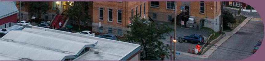
Démolition - 3, rue des Oblats
