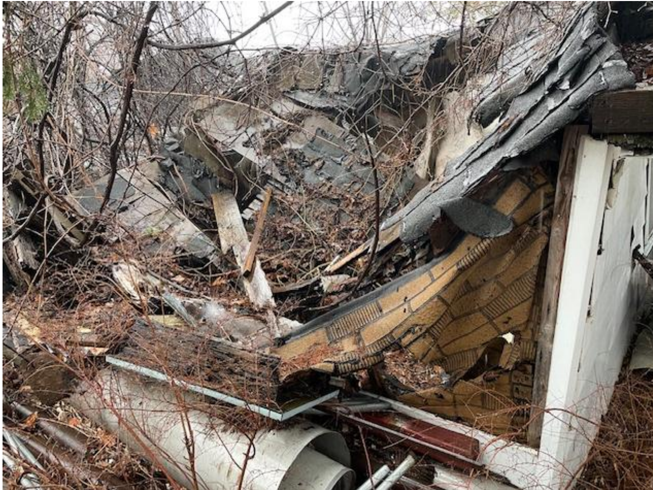
Démolition - 3, rue des Oblats
