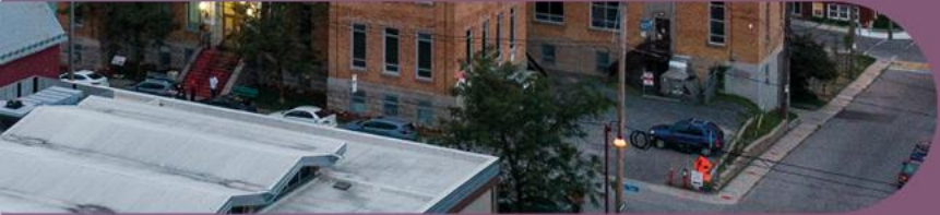
Démolition - 64, rue North
