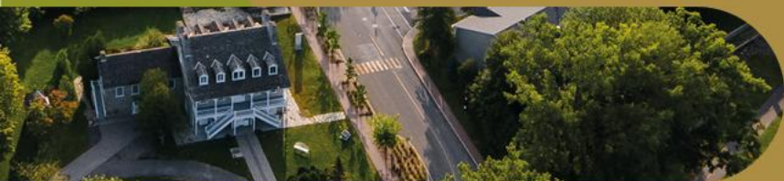
Démolition - 64, rue North
