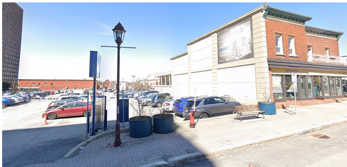
Bâtiment aux 59-61, rue Eddy
