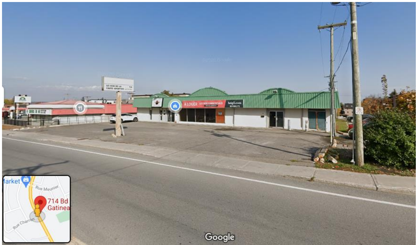
Vue sur le site (714 et 716 boul. Saint-Joseph)
