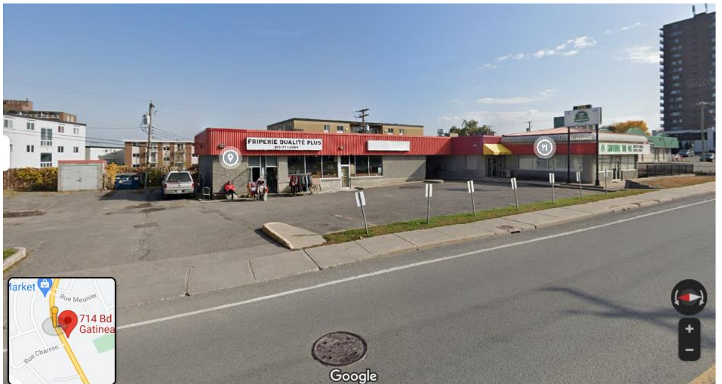
Vue sur le site (728 et 730 boul. Saint-Joseph)
