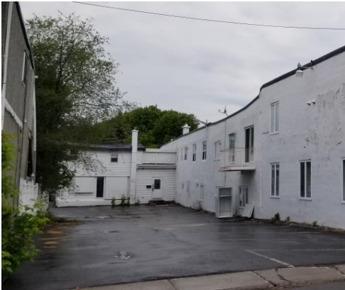
103-105, boulevard des Allumettières – vue sur la cour arrière donnant sur la rue Kent
