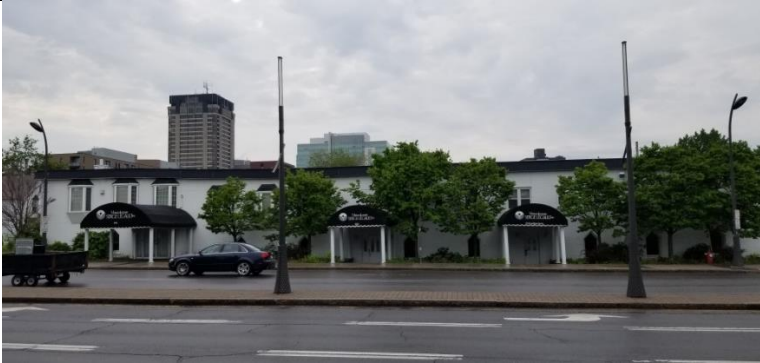
103-105, boulevard des Allumettières – vue de la façade nord donnant sur le boulevard des Allumettières
