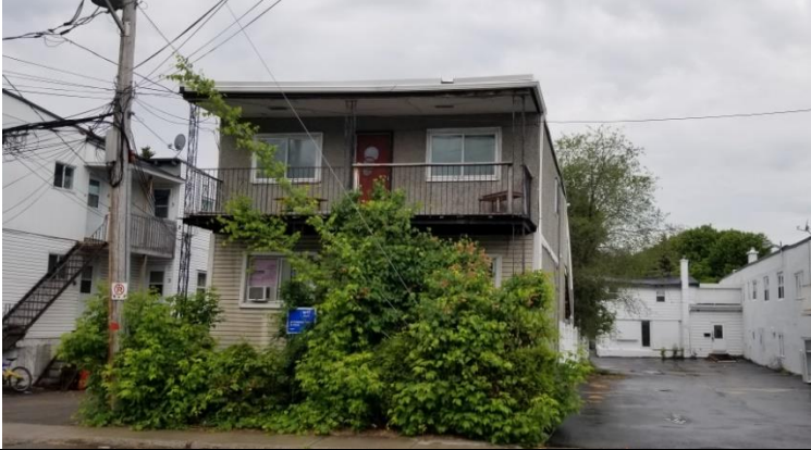
135, rue Kent – vue sur la façade principale
