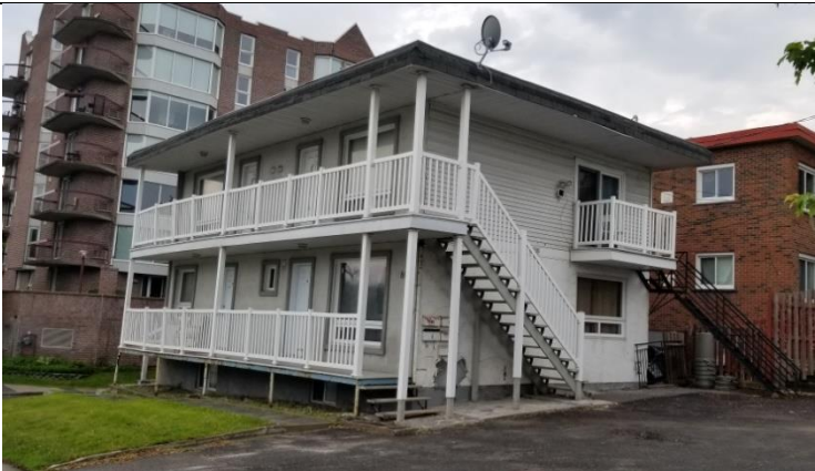
89, boulevard des Allumettières – vue des façades avant et latérale droite
