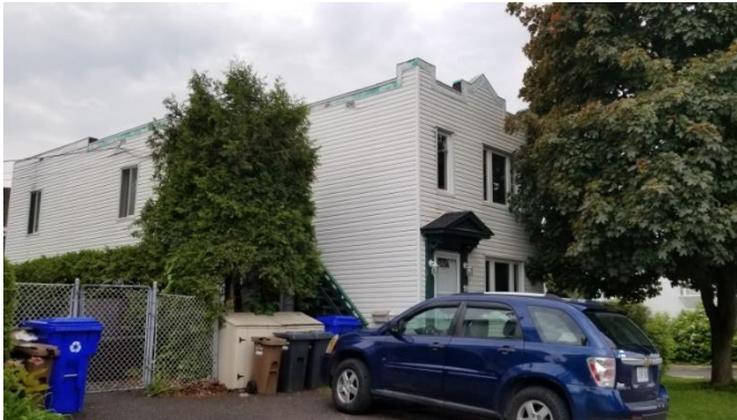
99, boulevard des Allumettières – vue de la façade principale et la façade latérale gauche
