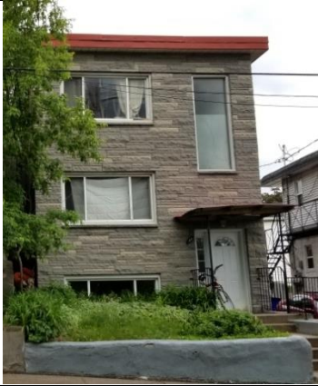
111, rue Dollard-des-Ormeaux – vue sur la façade principale
