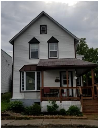
136, rue Kent – vue sur la façade principale
