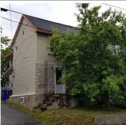
109, rue Dollard-des-Ormeaux – vue sur la façade principale
