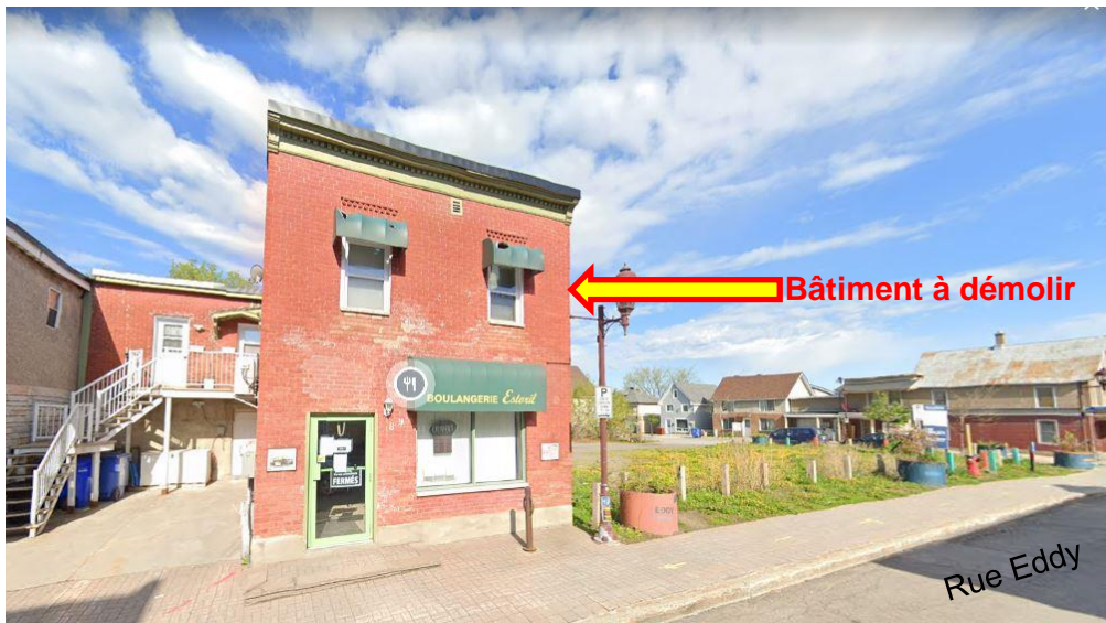
Vue du site d'intervention à partir de la rue Eddy
