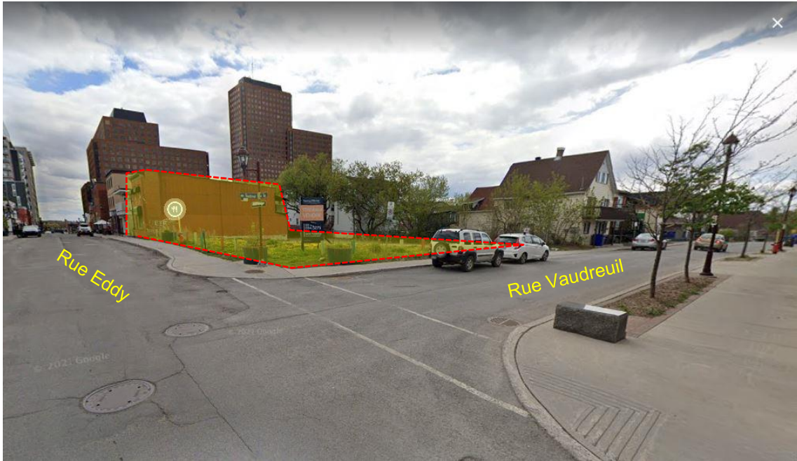
Vue du site d'intervention à partir de l'intersection (rues Eddy et Vaudreuil)
