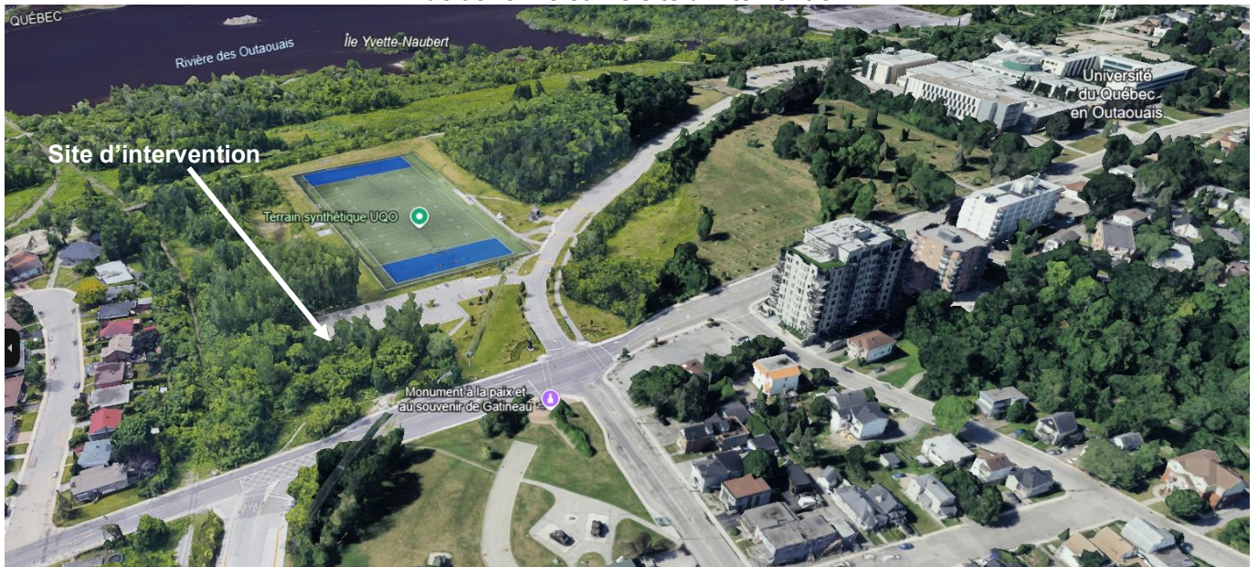
Vue aérienne sur le site d'intervention
