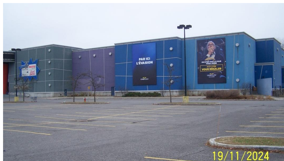
Section de la façade avant visée par les travaux d'agrandissement
