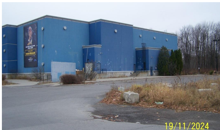
Façade latérale Ouest (droite) visée par les travaux d'agrandissement
