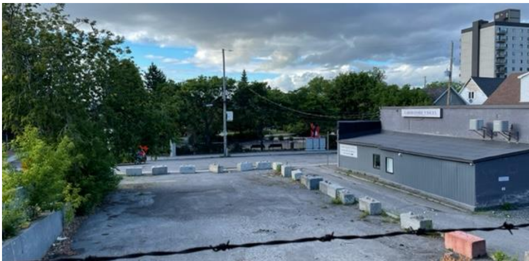
Vue à partir du terrain adjacent à la ligne arrière
