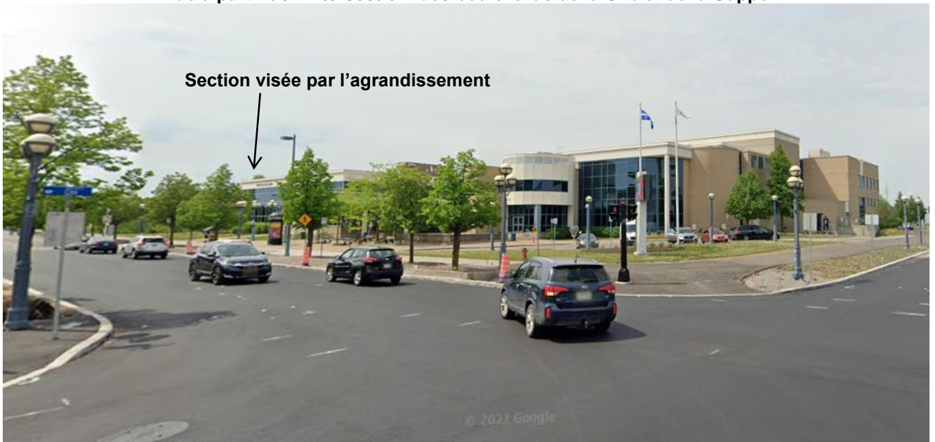
Vue à partir de l'intersection des boulevards de la Cité et de la Gappe
