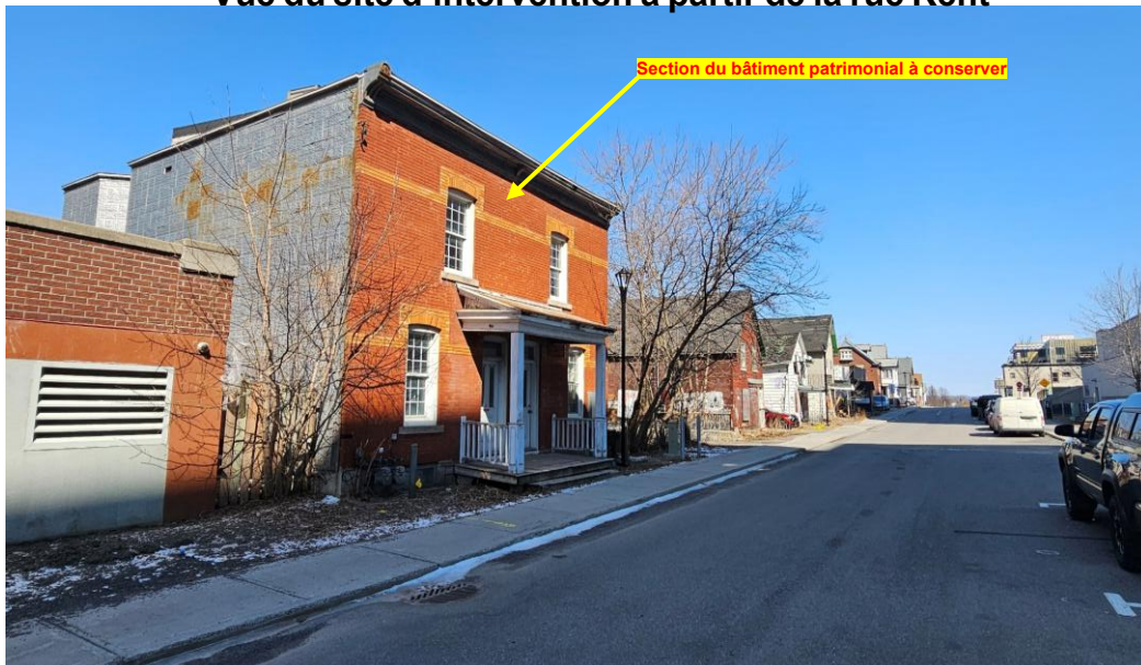
Vue du site d'intervention à partir de la rue Kent
