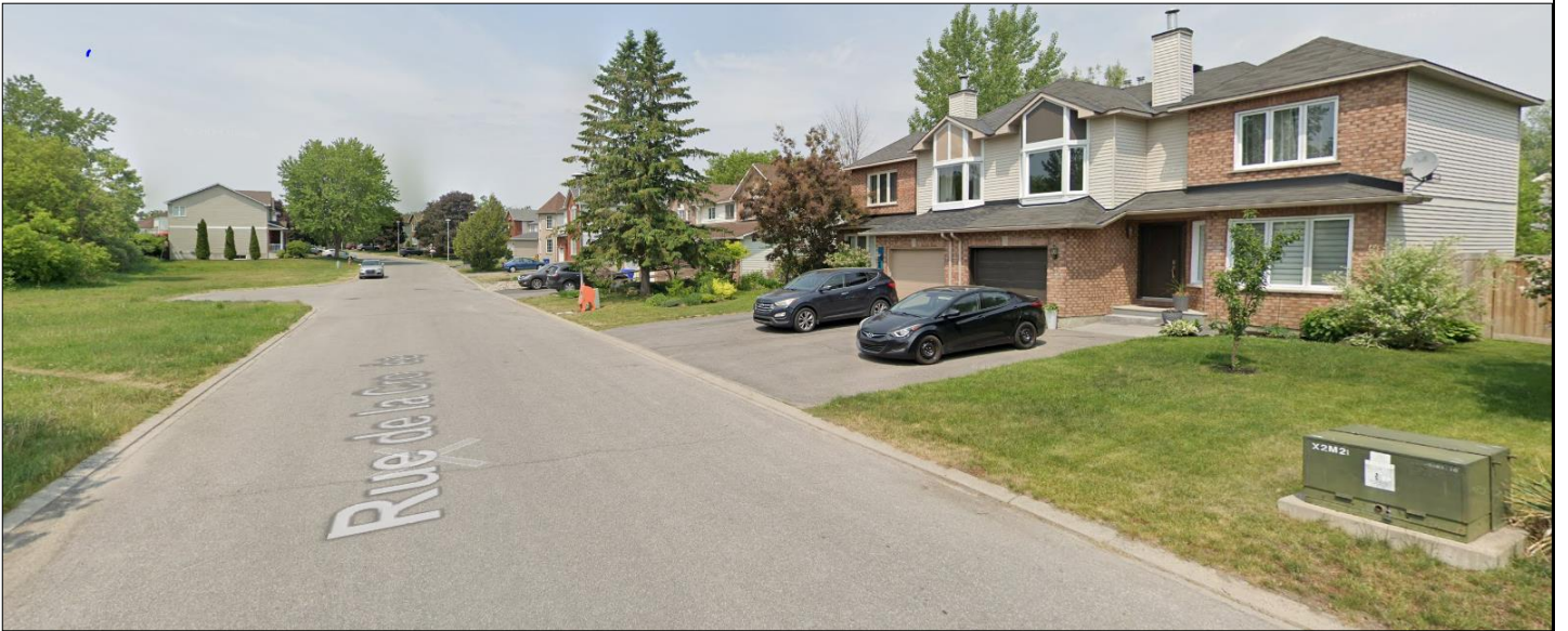
Bâtiments unifamiliaux existants localisés sur la rue de la Croisée, au nord du projet
