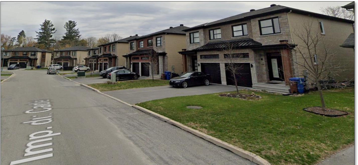
Bâtiments unifamiliaux jumelés existants localisés sur l'impasse du Cadet, à l'ouest du projet
